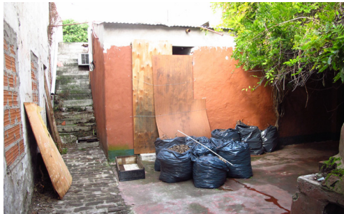
El baño de chapa construido en el patio trasero.
