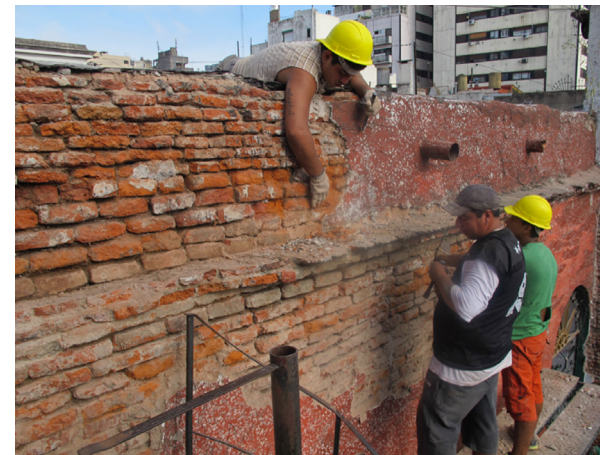
Rolando, José Luis y David removiendo el revoque en el patio delantero.
