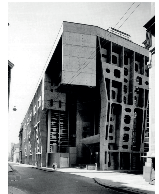
Banco Hipotecario (ex Banco de Londres), construido en 1959.
